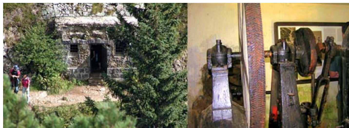
Celkový pohled na vodárnu v Obřím dole a detail strojního zařízení trkače. Foto J. Čermák
