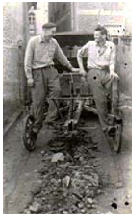
Závěsné zařízení k vozu Gaz na pokládání kabelů zkouší v Josefově uličce Štorkán a Čermák.
