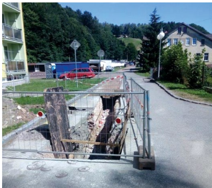
oprava vodovodu Rýchorské sídliště
