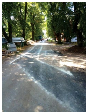
kanalizace Lipová ulice
