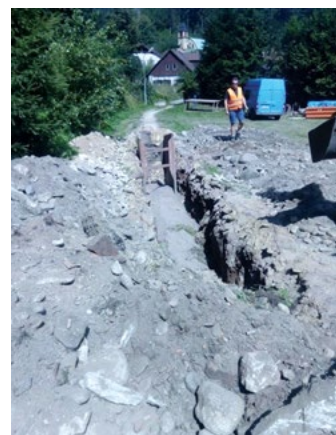
kanalizace Spojovací ulice
