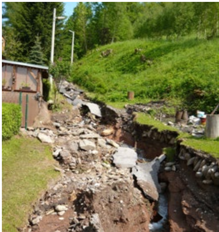
Maršovská ulice po povodni
