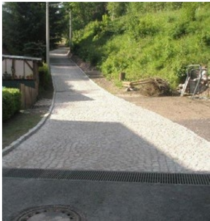
Maršovská ulice po opravě
