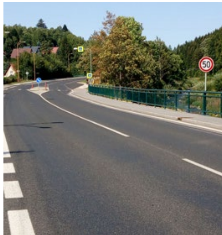
Přechod a chodník Maršov II
