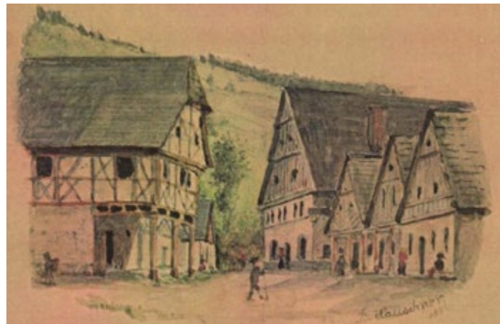
Obecní sýpka na kolorované kresbě B. Hauschnera z roku 1884 a po přestavbě na hostinec
