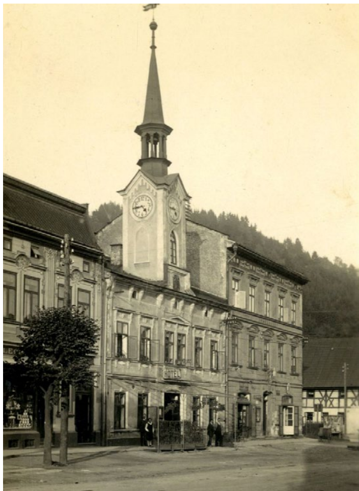
Holičství Josefa Dittricha sídlilo téměř polovinu století v budově dnešního Městského úřadu v přízemí vlevo.
