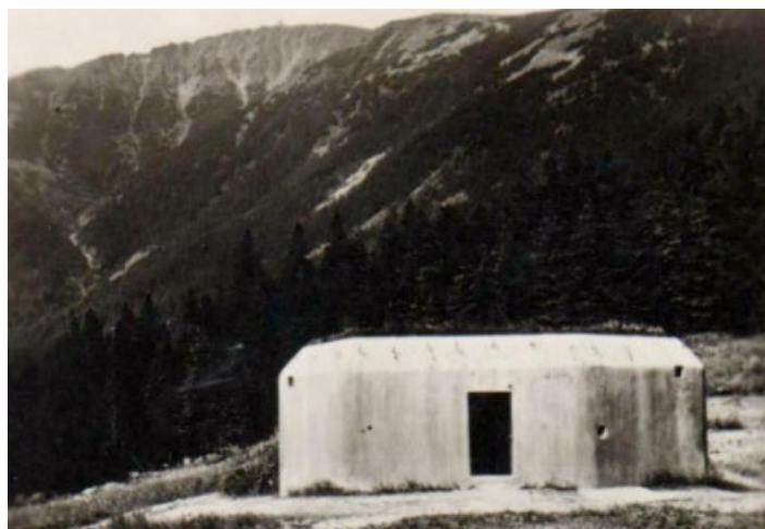
Objekt Z3 104/A-120 krátce po dokončení
