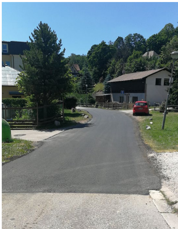
část komunikace na Pietteho náměstí, od vjezdu ze silnice na Janské Lázně směrem k Rýchorskému sídlišti.
