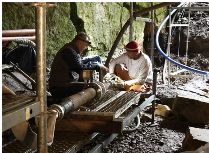
Montáž čerpadel a průtokového vodoměru
