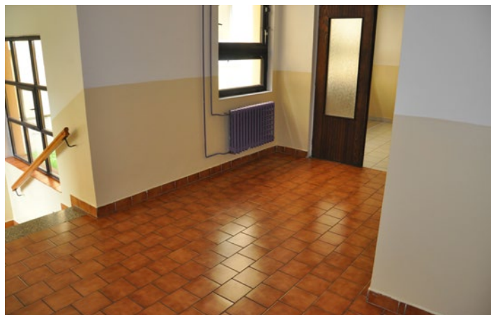
Vymalované prostory před školní jídelnou 2
