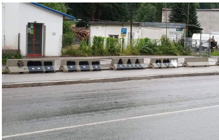
Betonové zábrany města před velkým JIPem
