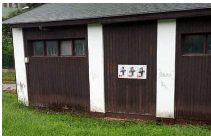
Trafostanice ČEZ vedle autobusového nádraží
