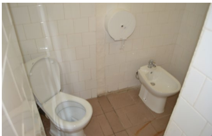
Dívčí záchody ve 2. poschodí – před rekonstrukcí
