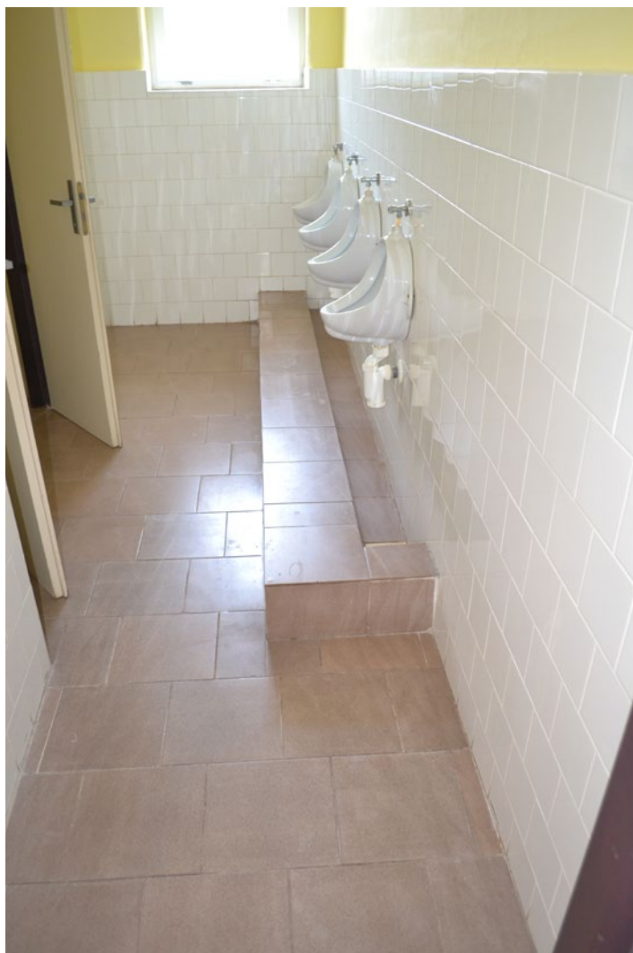
Chlapecké záchody v 1. poschodí – před rekonstrukcí
