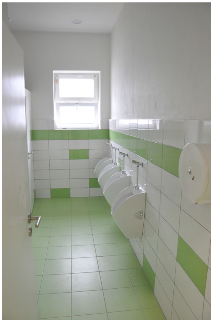
Chlapecké záchody v 1. poschodí – po rekonstrukci
