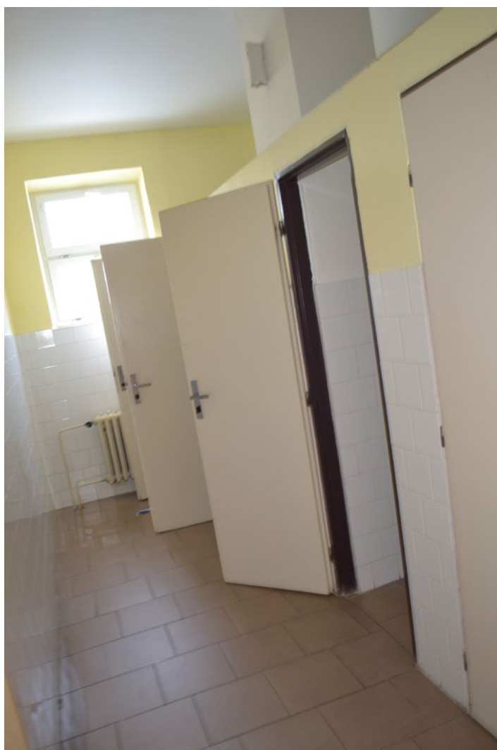
Dívčí záchody ve 2. poschodí – před rekonstrukcí
