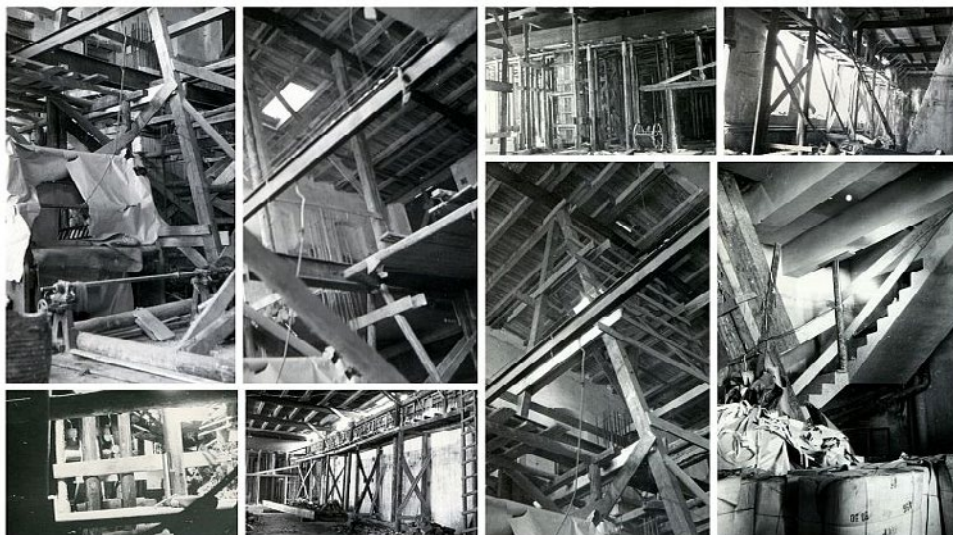
Boční pohled a změt tesařského díla uvnitř objektu
