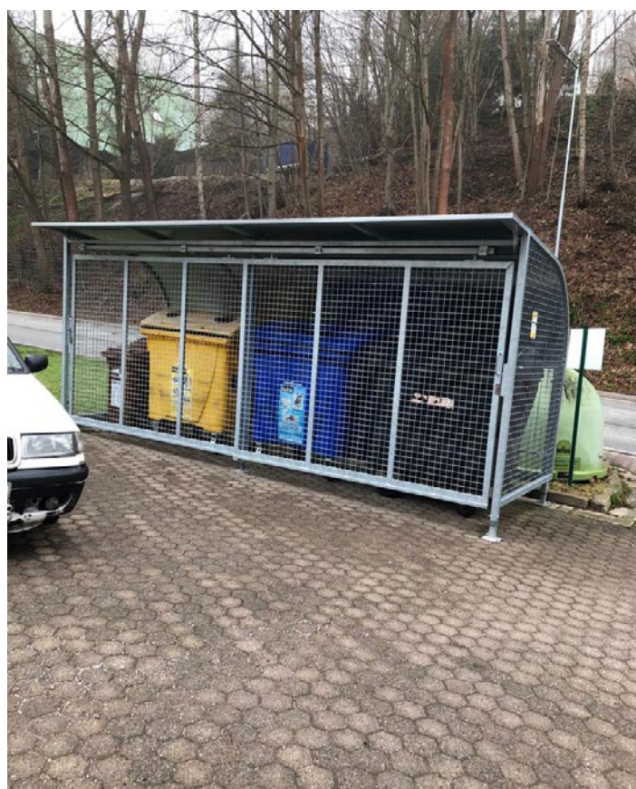
Kontejnerový přístřešek v Lázeňské u bytových domů č. p. 314 a 315
