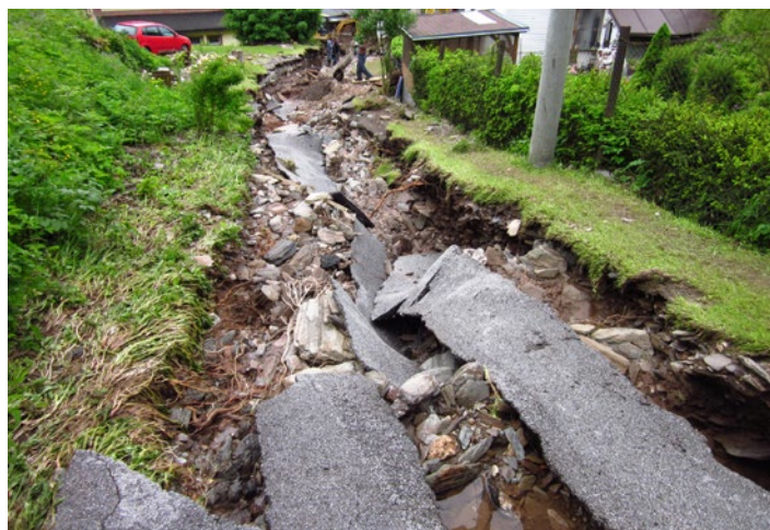
Silnice v Maršovské směrem k zahrádkám
