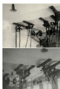
Budova truhlárny v polovině 20. stol. / Demolice staré podlahy / Transmise odřezával autogenem klempíř Josef Vít / Řemenový pohon přes transmise
