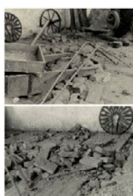
Budova truhlárny v polovině 20. stol. / Demolice staré podlahy / Transmise odřezával autogenem klempíř Josef Vít / Řemenový pohon přes transmise
