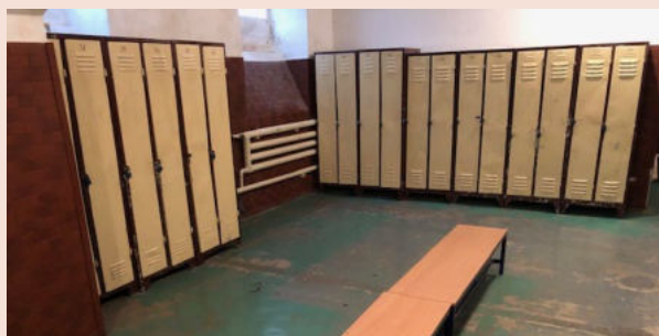
Šatna před rekonstrukcí
