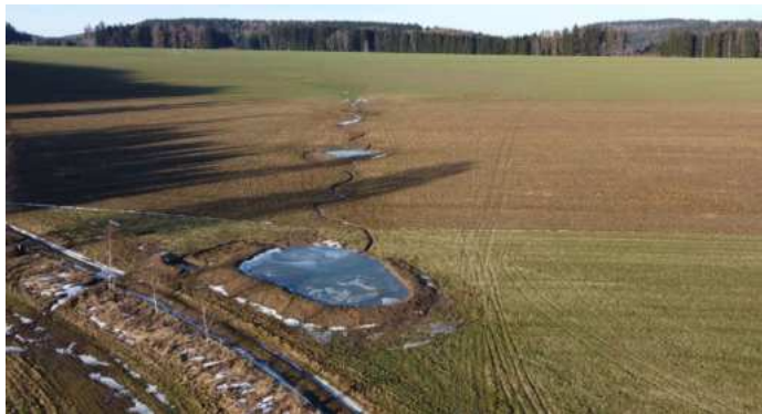
Foto od poloviny kaskády směrem nahoru ze dne 29. 1. 2024, těsně po dokončení hrubých zemních prací. Přínos: díky souhlasu vlastníků vyvedena voda z meliorací na povrch do občasného potůčku, snížena eroze postupně i vlivem zatrávnění prakticky na nulu, vznik nového mokřadu, snížení rychlosti odtoku vody z meliorací i z ploch v této terénní sníženině. Zdroj: archiv Živá voda
