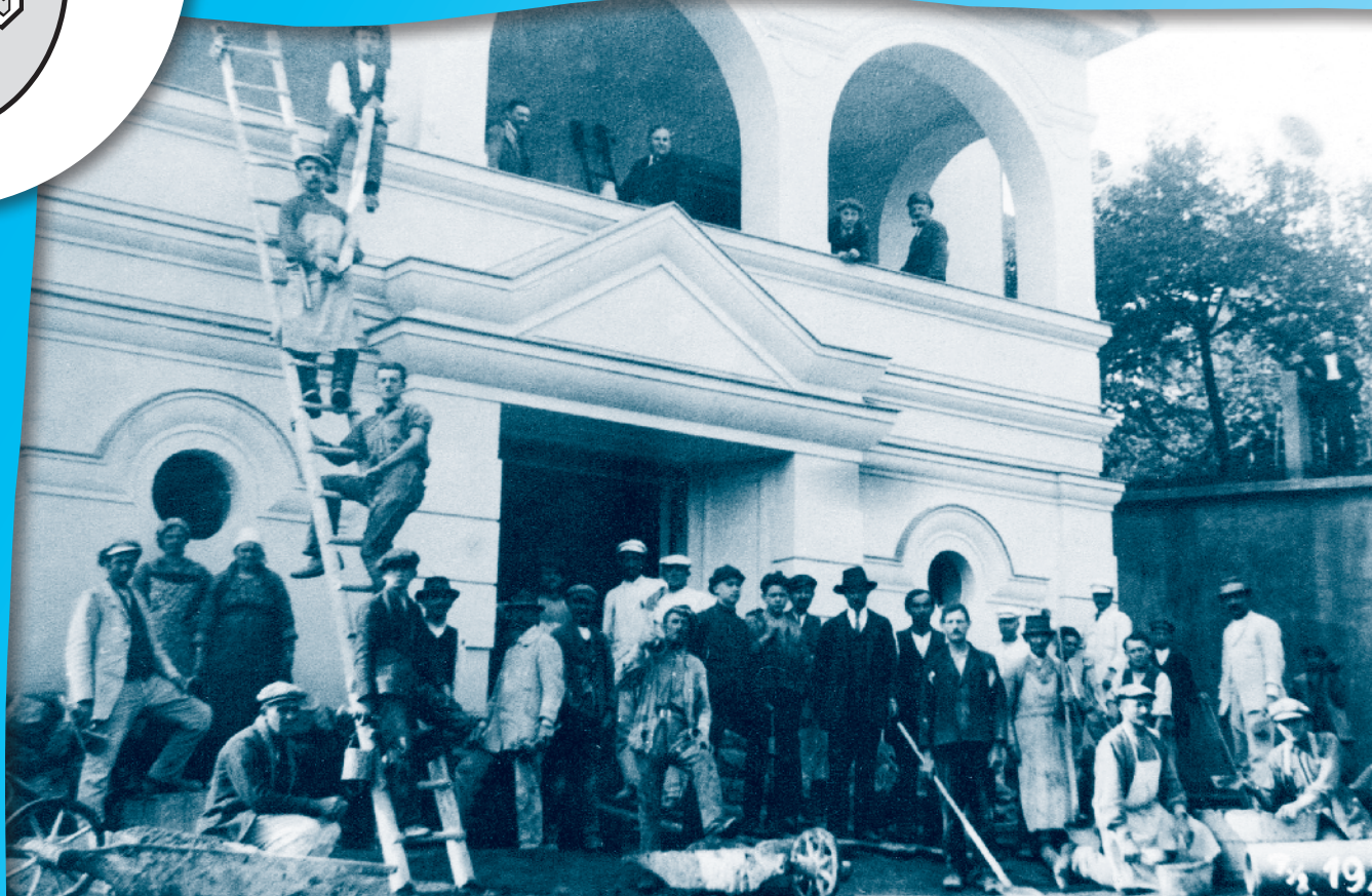
Snímek pořízený 7. srpna 1925, dva dny před slavnostním odevzdáním Husova sboru k bohoslužebným účelům.
