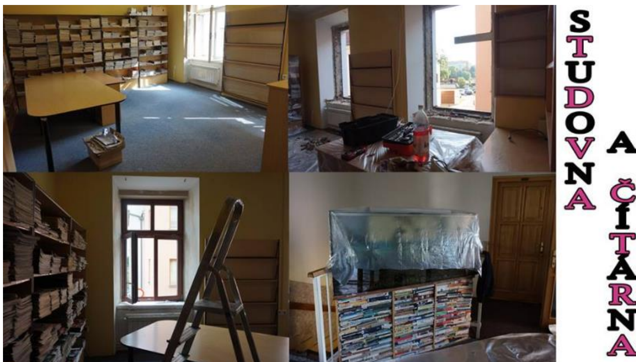
Obrázek 53: Výměna oken v 1. patře - studovna
