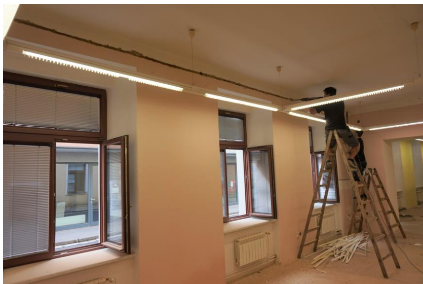
Obrázek 33 – pracovalo se na novém rozvodu elektřiny v dospělém ...
