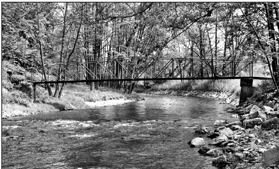
Řečiště, kde stála hráz (foto r. 2005)
