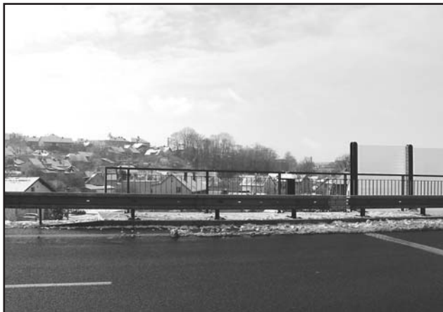
Budování protihlukové stěny na mostu přes Zdobnici.
