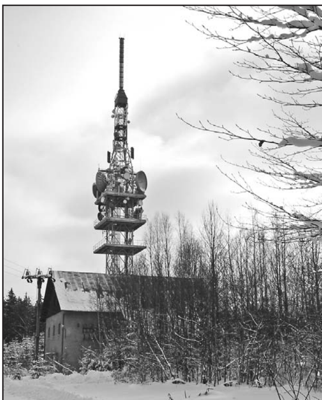
Telekomunikační věž na kótě 589 m.n.m.
