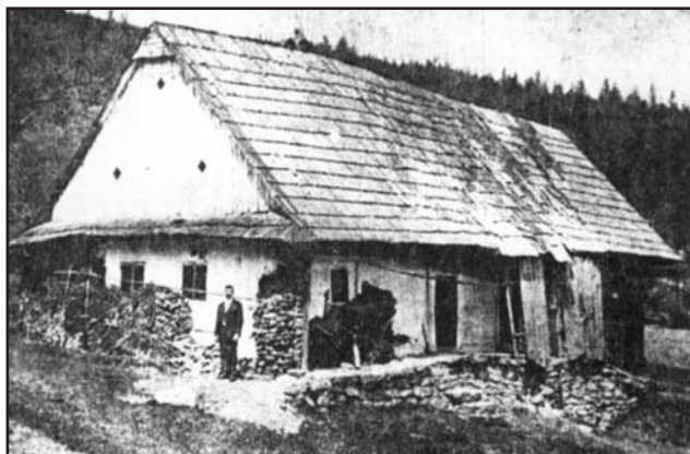
Zastávce Rybná n. Zd. musel ustoupit dřevěný dům patřící samotě Pekelec (čp.3)
