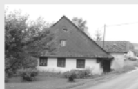
33CH0667 Chalupa Jamné n. O., okr. ÚO, 3+1, dům je po částečné rekonstrukci, stodola, kolná, pěkné klidné místo na konci obce. Celk. plocha pozemku 781 m 2 . CENA: 490.000,- Kč
