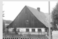
33CH0976 Rekreační chalupa v obci Lichkov. Bývalá zemědě- lská usedlost. Nutná rekon- strukce. Pozemek: 3132m². CENA: 330.000,- Kč
