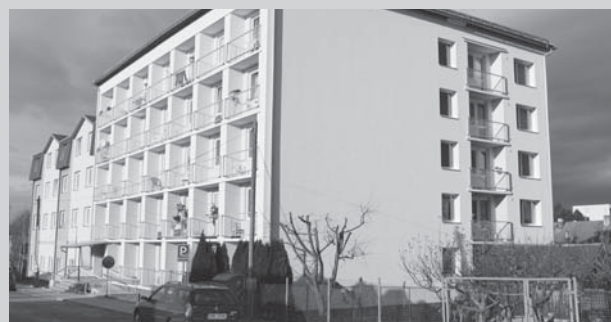
Zateplení Domu s pečovatelskou službou
