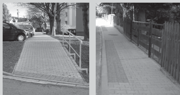
Nové chodníky v ulici Struha, Na Struhách, Jůnova před DPS
