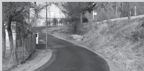
Rekonstrukce komunikace v Rošti
