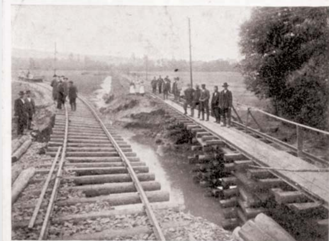
VAMBERK. Povodní stržený most železný na „Zdobnici“ a poškozená trať místní a sev.-záp. dráhy.
