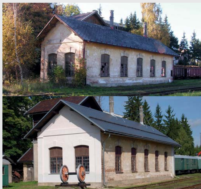
Budova výtopny prochází kompletní renovací. Díky nadšení místních byla zachráněna v hodině dvanácté
