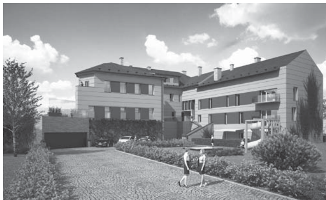
Společnost Rezidence radniční s.r.o. představila záměr rekonstrukce objektu na bytový dům
