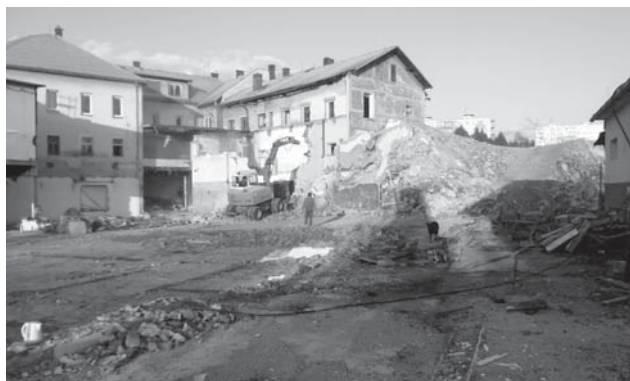
V areálu masny probíhá demolice bývalých provozních objektů
