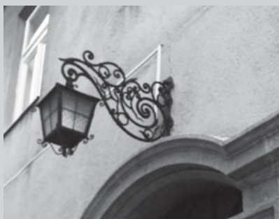
LUCERNA nad vchodem do dnešní knihovny, dřívějšího muzea, je dílem Oldřicha Doležala z roku 1968
