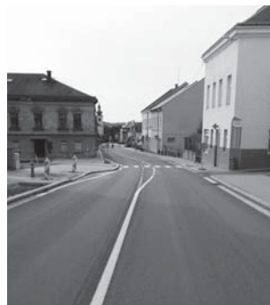
Stávající stav, kdy se jízdní pruhy stáčí směrem k lékárně.
