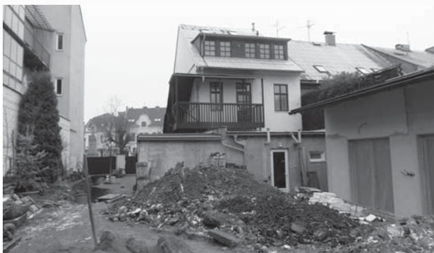
Dvorek při čp. 322 ve Vamberku - výkopy pro kanalizaci
