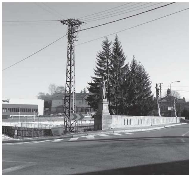
V rámci rekonstrukce elektrického vedení zmizí pod zem všechny dráty v okolí mostu
