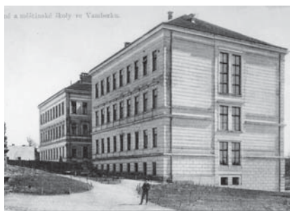
budova základní školy ve Vamberku v roce 1910
