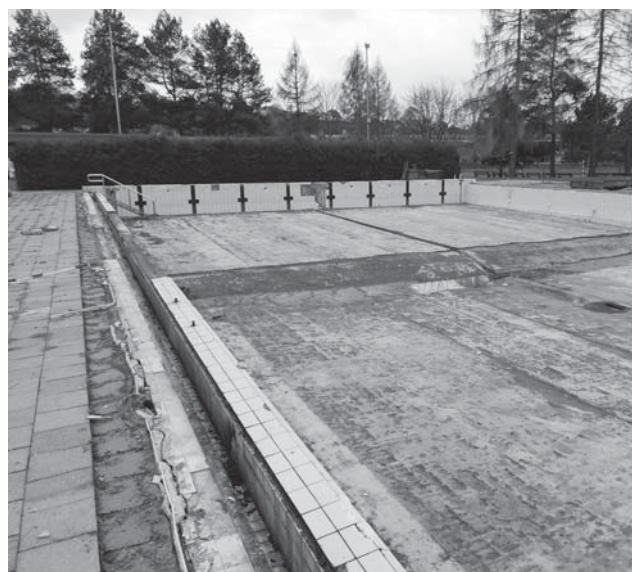
Rekonstrukce začala přípravnými pracemi. Všechny kachličky a nepevné části betonu musí být odstraněny.
