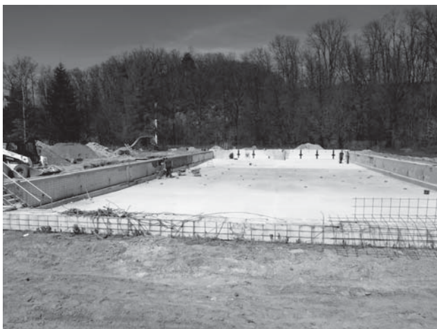
Dno bazénu s kompletními rozvody je již hotové. Ve střední části se snížila hloubka bazénu na 120 cm. Bazén tak bude bezpečnější a voda se více prohřeje.
