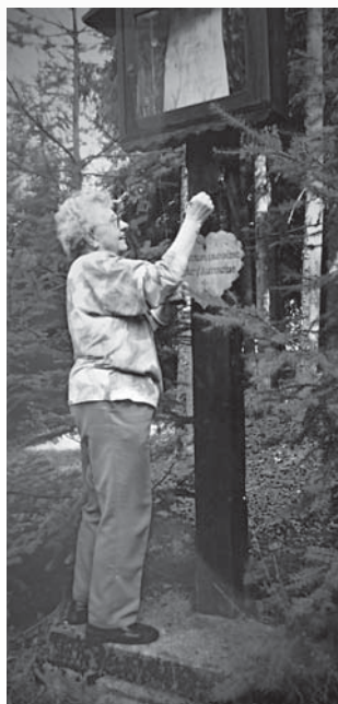
Oprava sloupku se svatým Antoníčkem (23.09.2010), Zdeňka Jarešová
