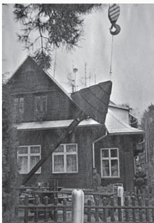
Instalace zvoničky u chaty Na Vyhliďce po předchozí renovaci (12.11.2008).
