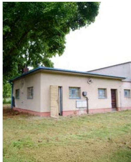
Budova Vamberecké vody před rekonstrukcí
