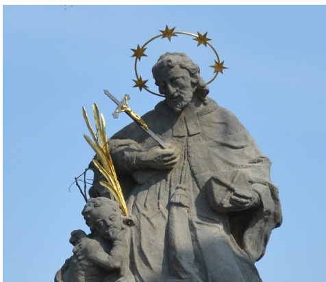
Sv. Jan po opravě
