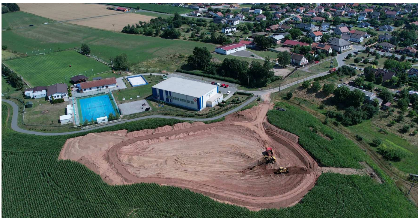
Stav k polovině července 2023. Je jasně vidět tvar a velikost budoucí nádrže olemované hrází. V horní části vedle cyklostezky bude přírodní potrubí dešťové vody a podzemního pramene z původní studánky. V pravé části snímku je vidět zahájení výkopových prací na odtokovém potrubí.
