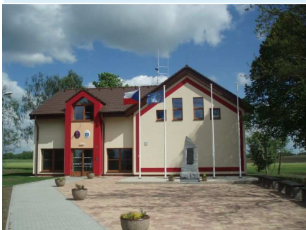
Němčice. Novostavba z roku 2014
