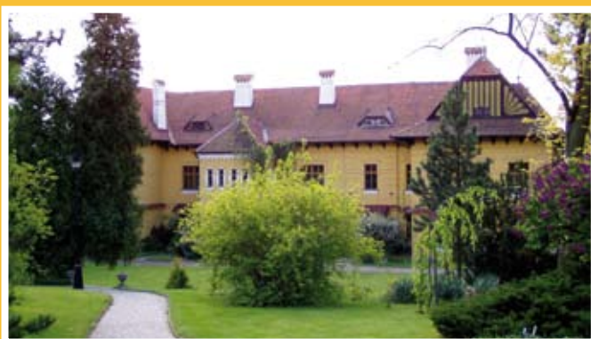
Zahradnická škola v Brně-Bohunicích
