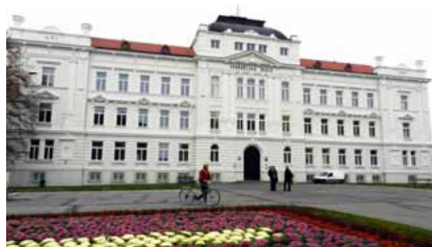
Budova zemědělské školy v Táboře
