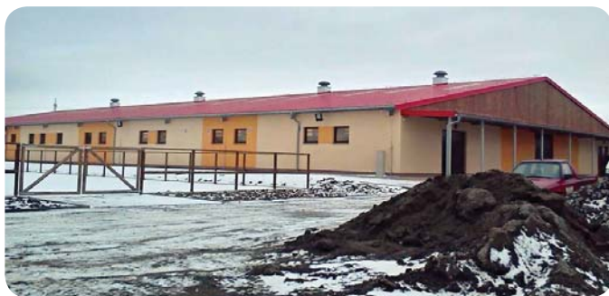
Nová jezdecká hala s venkovní jízdárnou
