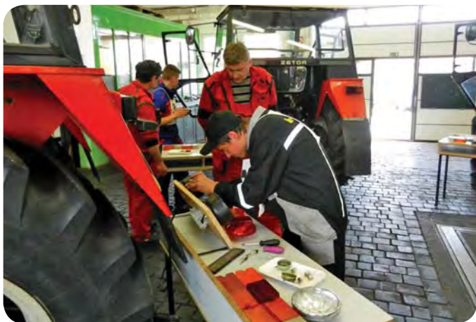
Opravy elektroinstalace a elektrického příslušenství – montáž žárovek na traktoru a modelu elektroinstalace přívěsu, dle vyhlášky, zkompletovat světla, zapojit sedmipólovou zástrčku
