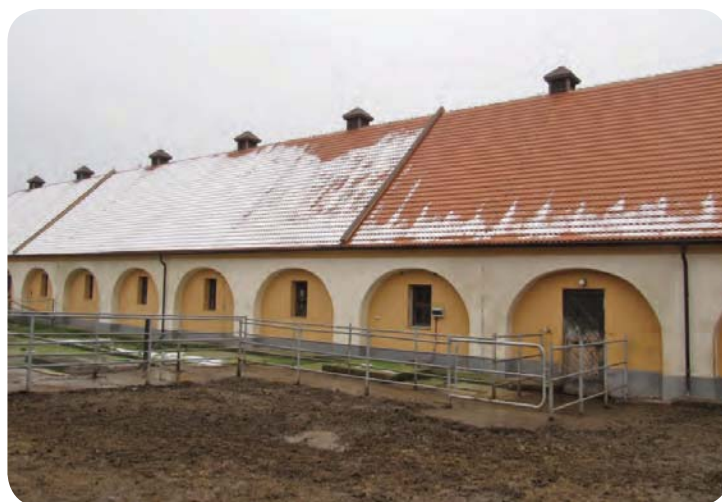
Starý kravín v Požárech prošel rozsáhlou rekonstrukcí
