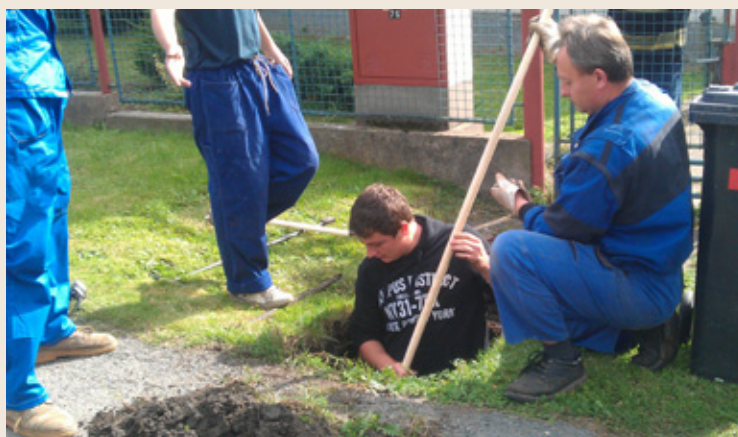
• Pomoc hasičů při čištění obecní kanalizace.
