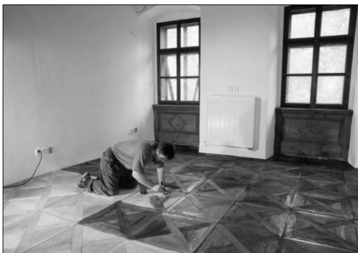
V jedné místnosti bude podlaha sestavena ze zbytků původních podlah Foto V. Prostředník
