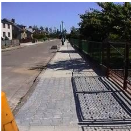
Ulice Zahradní – oprava obou stran
