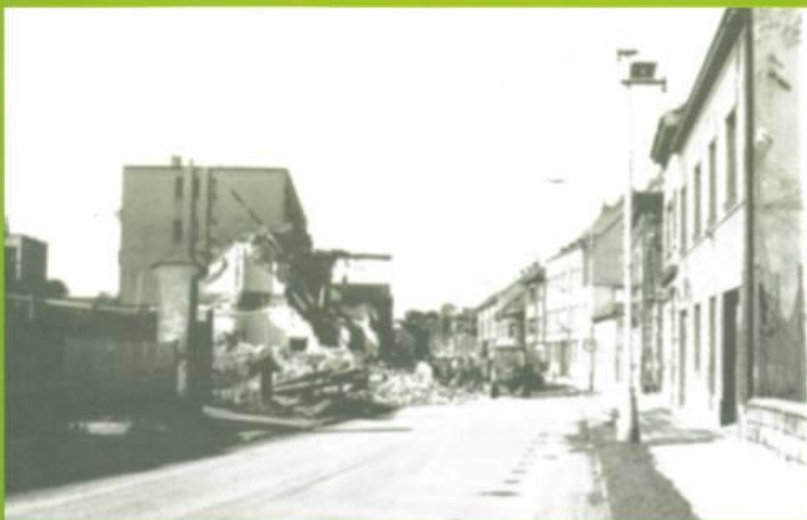
Výstavbou nového bytového domu se po delším období změní vzhled hlavní Palackého ulice
