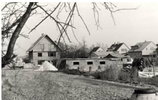
Výstavba Husovy ulice – r. 1985
