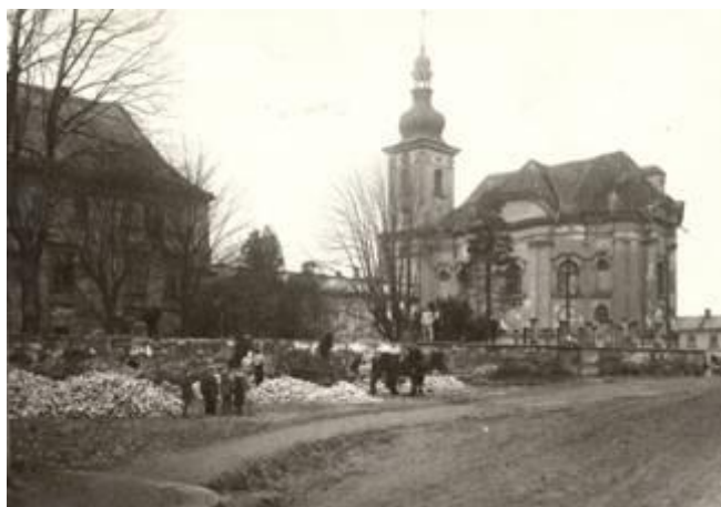
Rozebírání zámecké zdi
