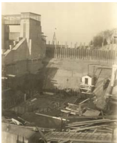
Stavba elektrárny (nedatováno)
