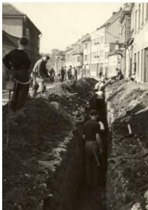
Výstavba vodovodu v Palackého ul. – rok 1960
