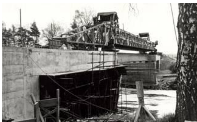
Stavba nového mostu – pokládání mostnice – jaro 1981
